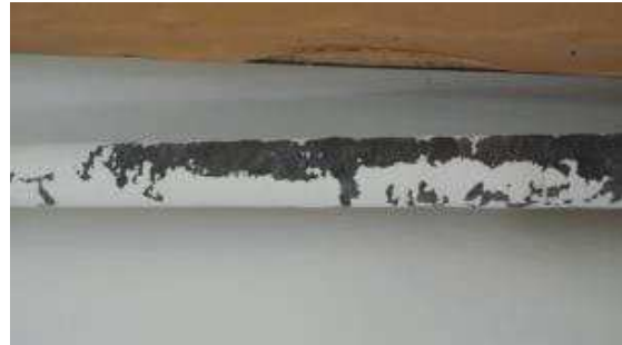
Foto 45: particolare tubazione presso locali in concessione a TTP
