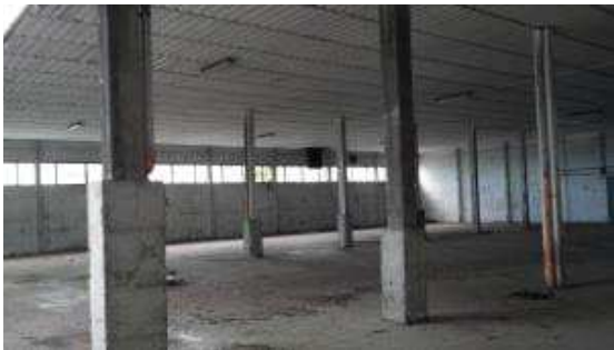
Foto 30: controsoffitto interno, veduta generale anno 2016
