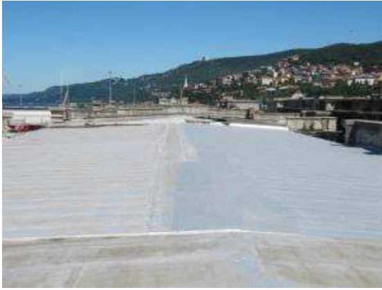
Foto 50: veduta generale del tetto
