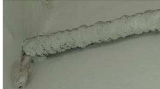
Foto 41: particolare tubazione n.1 presso vecchi bagni
