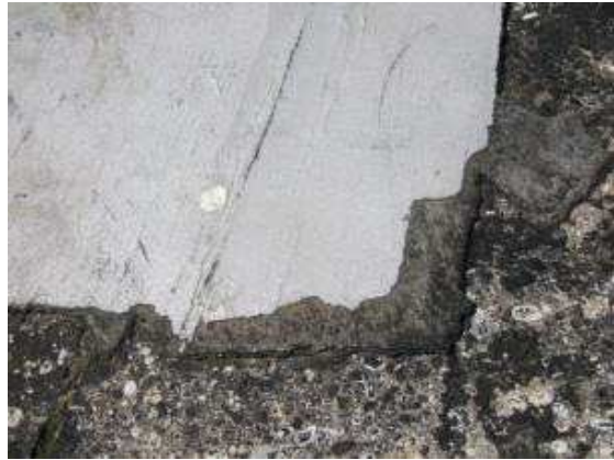
Foto 53: particolare, guaina impermeabilizzante
