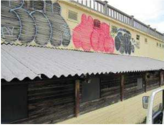
Foto 3: manufatto dopo l'incapsulamento, anno 2014
