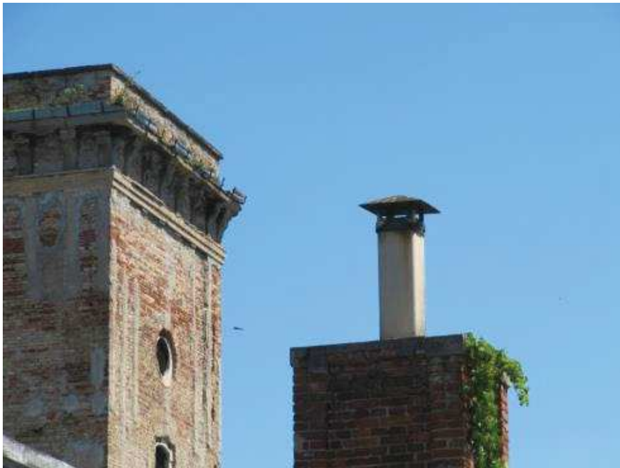
Foto 39: particolare del camino, anno 2016
