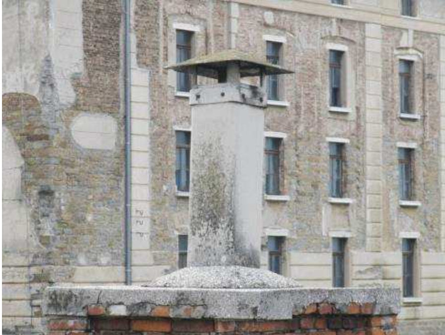
Foto 38: particolare del camino, anno 2014
