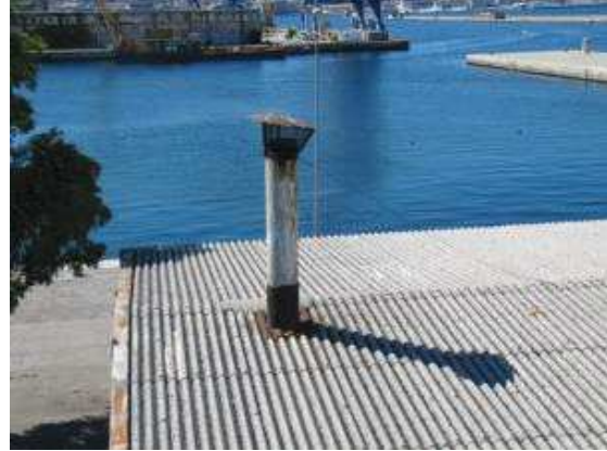
Foto 35: particolare canna fumaria (angolo Sud Est), anno 2016
